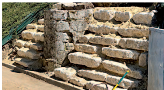
Avant/après, rénovation des murets, des escaliers et du dallage de l'entrée de l'Hôtel de Ville de Moyvillers (60). Toutes les pierres ont été façonnées dans les ateliers de Saint-Pierre-Aigle avec montage à sec pour visualiser le rendu final.
